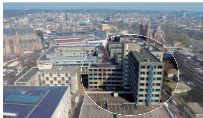
Prinsenhofgebouw, rechts op de foto, een negen verdiepingen tellende betonkolos uit 1986.
