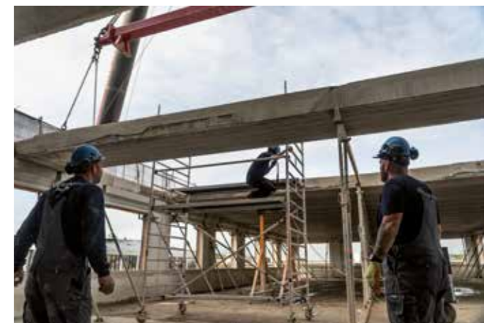
Demontage van de kanaalplaatvloeren in het Prinsenhofgebouw.
