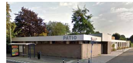
Het voormalige buurtcentrum Patio. Dit gebouw wordt grotendeels hergebruikt door Boschgaard.
